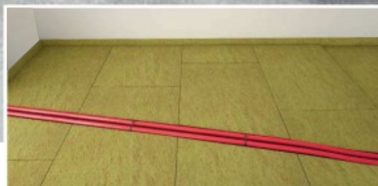
Rys. 4.2.2. Dwuwarstwowa izolacja z wełny mineralnej z przewodami instalacyjnymi na powierzchni stropu.
