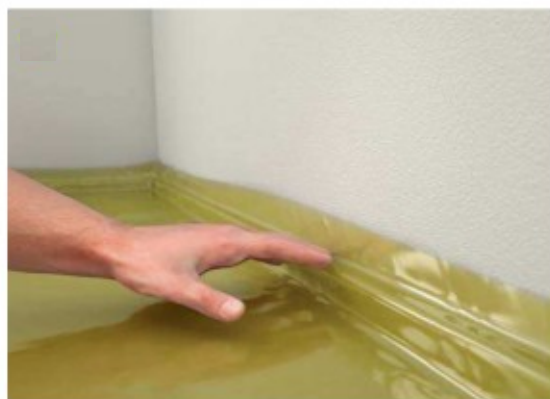
Rys. 4.2.3. Montaż folii ISOVER Stopair na warstwie izolacji z wełny mineralnej.
