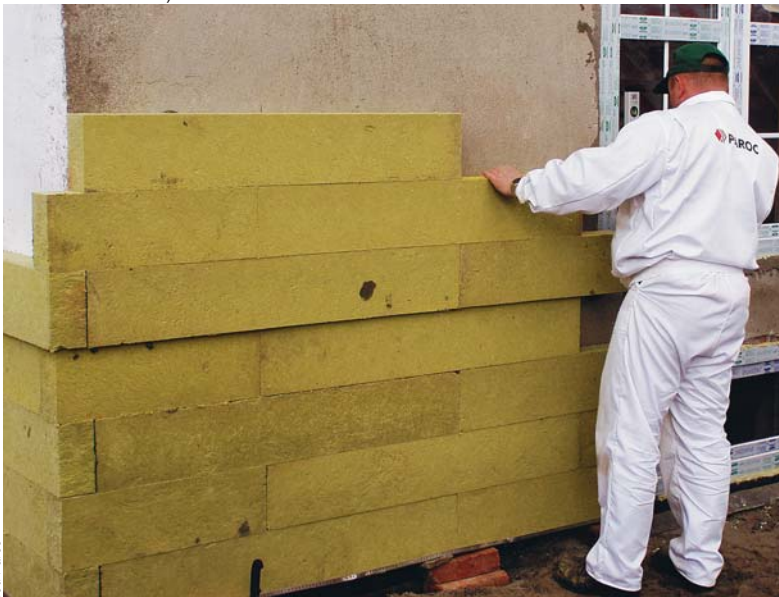
▲ Najpopularniejsze realizacje ścian domów jednorodzinnych – dwuwarstwowych, ocieplonych metodą lekką moką przy wykorzystaniu izolacji termicznej z wełny mineralnej i styropianu
