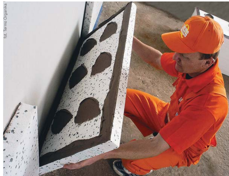
▲ Najpopularniejsze realizacje ścian domów jednorodzinnych – dwuwarstwowych, ocieplonych metodą lekką moką przy wykorzystaniu izolacji termicznej z wełny mineralnej i styropianu
