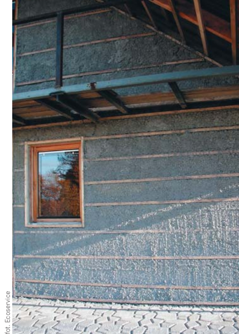
▲ Izolacja termiczna ścian w włókien celulozy
