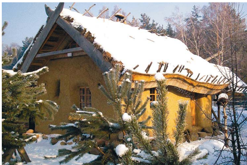
▲ Przykład domu zbudowanego z najbardziej ekologicznych i dostępnych materiałów, gliny, słomy, drewna i kamienia
