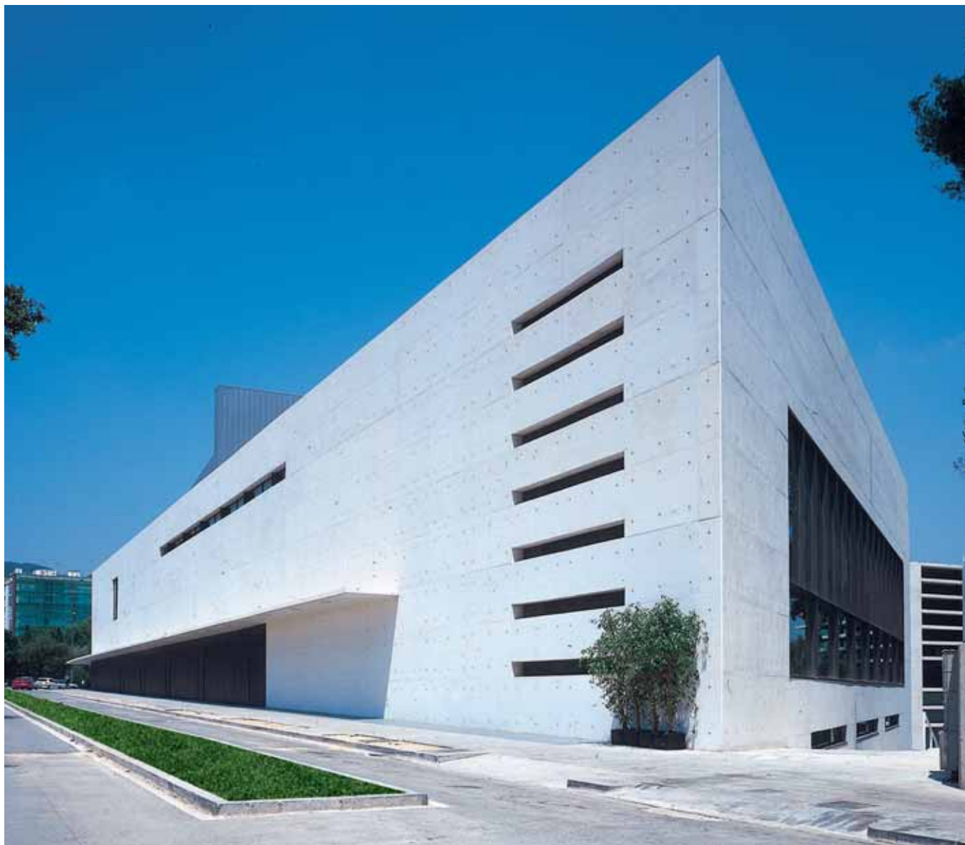
Zdjęcie nr 5 • Palacio de Congresos w Katalonii – instalacja przewodów klimatyzacyjnych z płyt URSA AIR
