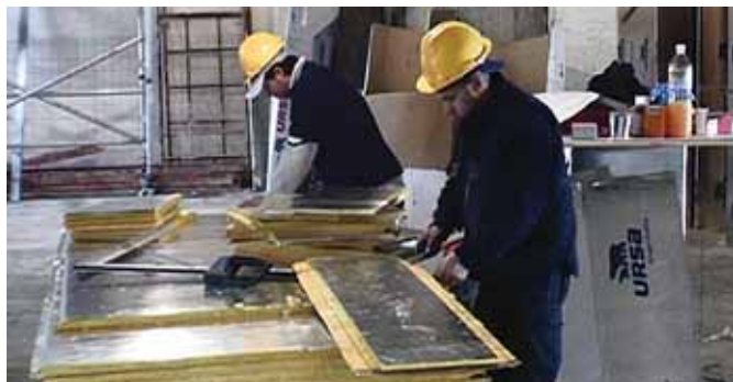
Zdjęcie nr 13 • Stanowisko pracy monterów
