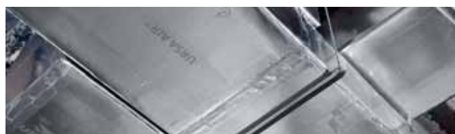
Zdjęcia nr 3 i 4 • Sieć przewodów wentylacyjnych z paneli URSA AIR
