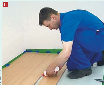
Panele łączone bezklejowo (a) lub za pomocą kleju (b)
