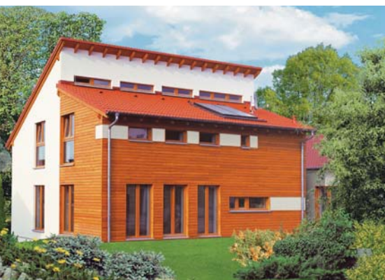
Dom pasywny wybudowany przez firmę BUDIMEX DANWOOD w Niemczech
