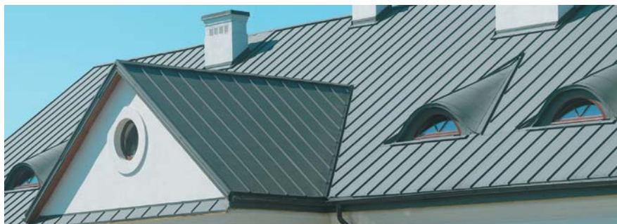
„Wole oka” efektywnie wykonane z blachy na rąbek stojący
