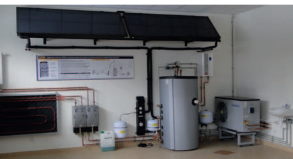
▲ Rysunek 1. Podgrzewacz Hewalex INTEGRA w układzie z kotłem wiszącym, pompą ciepła powietrze/woda oraz instalacją solarną
