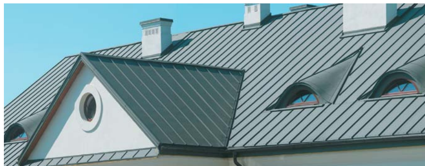
„Wole oka” efektywnie wykonane z blachy na rąbek stojący
