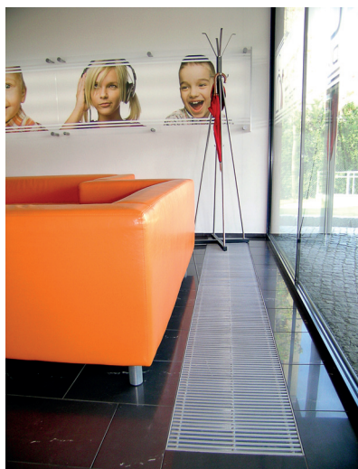
REGULUS-system CANAL VENT
