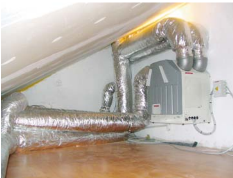
▲ Jeśli mechaniczną wentylację poddasza wyposażymy w rekuperator, umożliwi to znaczne zmniejszenie wydatków na ogrzewanie. Należy jednak pamiętać, by oprócz ocieplenia stropu zaizolować termicznie również przewody wentylacyjne
