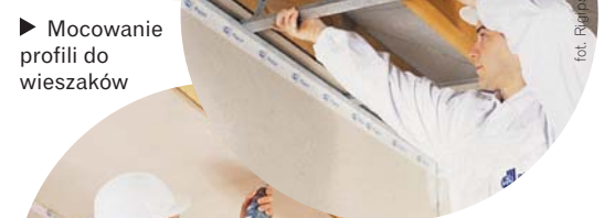
◀ Przykręcanie płyt g-k
