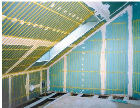
▲ Ogrzewanie ścienne nadaje się do zastosowania zwłaszcza w połączeniu z takimi źródłami ciepła, jak kocioł kondensacyjny czy pompa ciepła
