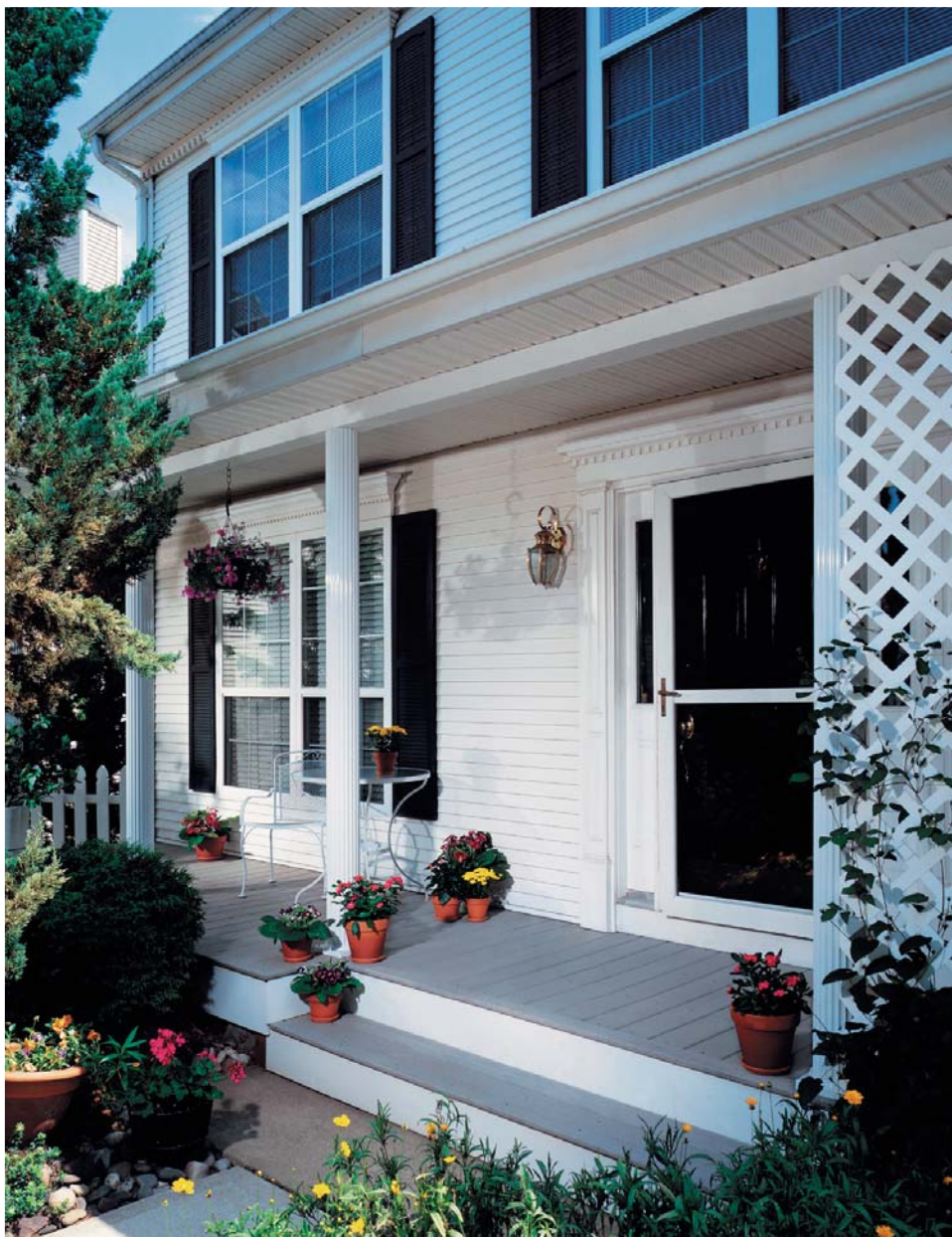
Elewacja z sidingu. Producenci oferują ten materiał w kilkunastu kolorach, ale wciąż najpopularniejszy jest biały. Panele, z których montowana jest elewacja, oprócz koloru mogą mieć różny kształt: mogą być płaskie lub łamane, gładkie lub z fakturą imitującą drewno
