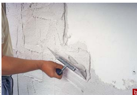
▲ Nakładanie tynku za pomocą agregatu (a) i ręcznie (b)
