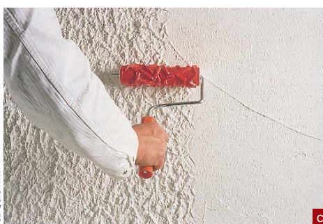
▲ Fakturowanie powierzchni za pomocą: kielni gładkiej (a), pacy zębatej (b) oraz wałka (c). Fakturowanie tynków należy wykonywać przed ich wyschnięciem
