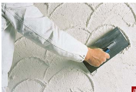
▲ Nakładanie tynku za pomocą agregatu (a) i ręcznie (b)
