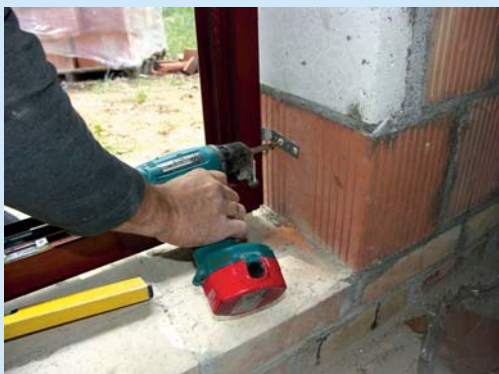
▲ Osadzanie okna w murze za pomocą kotew stalowych
