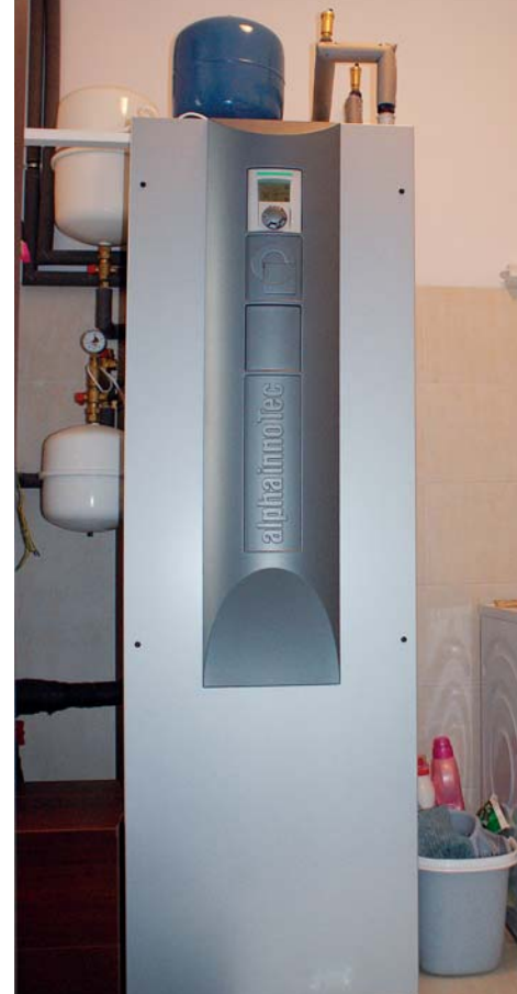
▲ Pompa ciepła Alpha-InnoTec typu solanka-woda o mocy 10 kW
