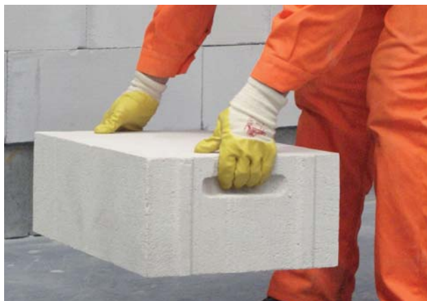
▲ Ściana z bloczków betonu komórkowego o gęstości zaledwie 300 kg/m 3 ma bardzo wysoką izolacyjność U \approx 0,2 \text{ W/(m}^2\cdot\text{K)} nawet gdy jej grubość nie przekracza 40 cm
