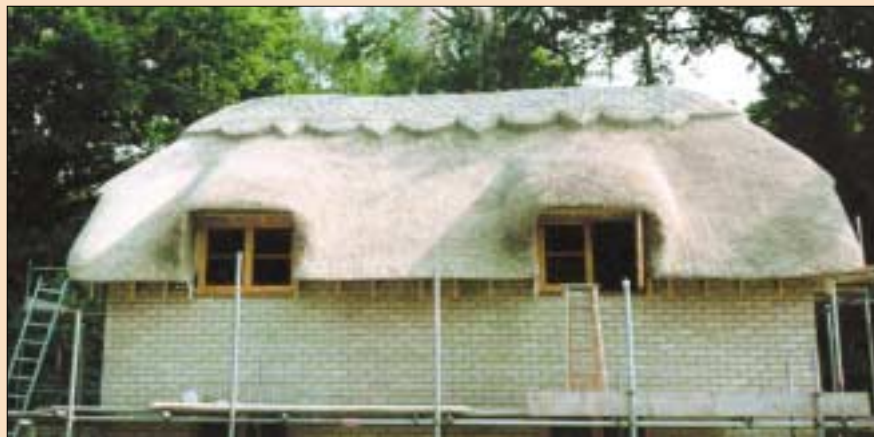
1 Niezwykle efektowne wykonanie trzcinowej kalenicy (fot. LML Ekodach)
