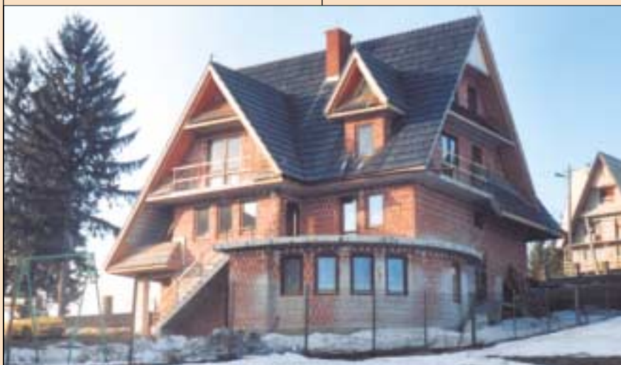
2 Dach kryty gontem (fot. H. Czerska)
