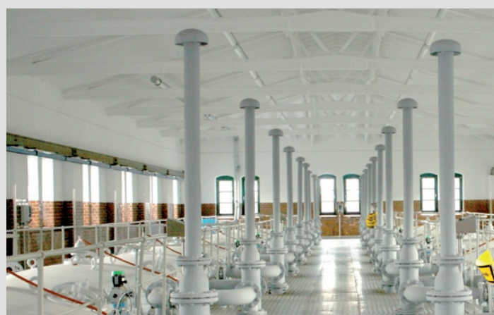
Powłoka KefaTherm w zakładzie wodociągów
