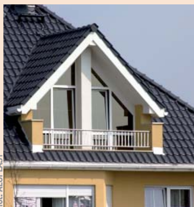
Poddasze użytkowe doświetla się lukarną lub montując okna dachowe
