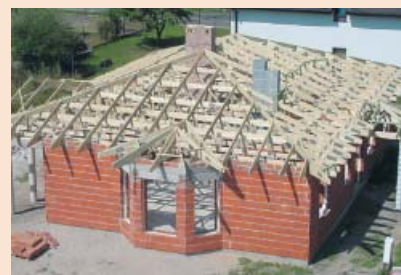
Drewno do budowy więźby dachowej najlepiej kupować w firmie, która dostarczy materiał odpowiednio przycięty, zaimpregnowany i wysuszony (fot. Mabudo)
