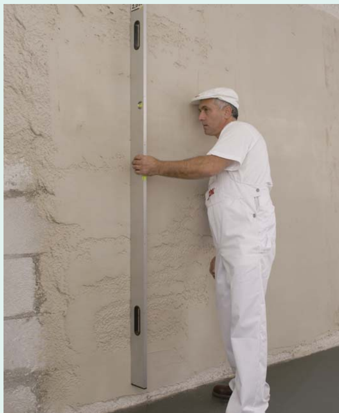
Powierzchnię narzutu wyrównuje się za pomocą metalowej łąty
