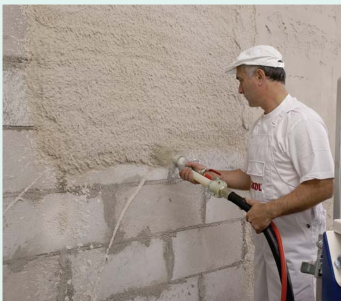
Tynki tradycyjne najwygodniej nanosić za pomocą agregatu tynkarskiego
