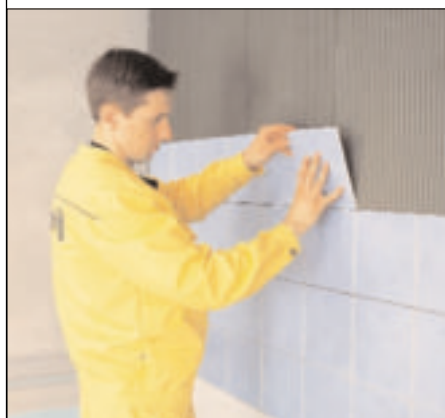
6 Płytki ceramiczne należy mocować elastyczną zaprawą klejową (fot. Henkel)
