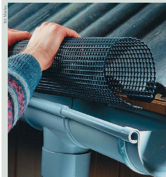
▲ Siatka z tworzywa sztucznego: uniemożliwia gromadzenie się liści czy szyszek w rynnach
