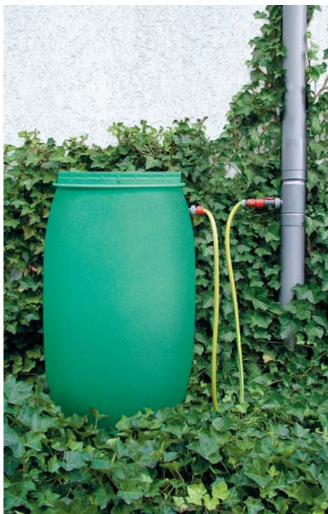
▲ Najprostszy i najtańszy zbiornik wody deszczowej to zwykła beczka z tworzywa sztucznego
