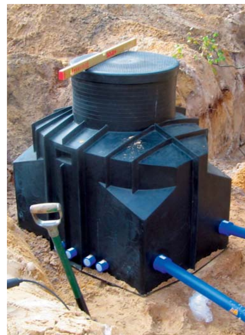
▲ Studzienka rozdzielcza, w której łączą się pętle kolektora poziomego (przed zakopaniem). Po prawej stronie widoczne są rury łączące to miejsce z pompą ciepła znajdującą się w budynku
