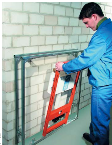
▲ Stelaże podtynkowe mocuje się na specjalnych szynach montażowych przykręcanych do ściany i podłogi. Ich zabudowa znacznie wycisza działanie przyborów sanitarnych
