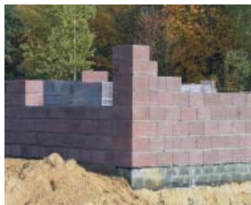
Ścianę jednowarstwową z elementów o dobrej termoizolacyjności warto pokryć tynkiem ciepłochronnym (fot. Betard - Prefabrykаты Budowlane)
