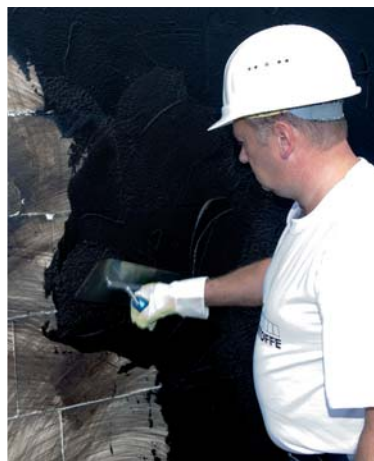
Nakładanie bitumicznej izolacji grubowarstwowej z BOTAZIT® BM 92 Schnell/Winter, BM1 na zagruntowane podłoże z BOTAZIT® BE901
