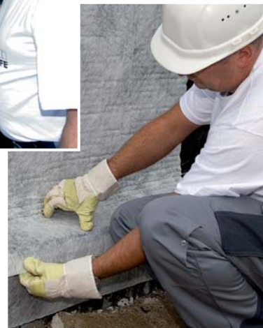
Klejenie płyty ochronno-drenażowej BOTAZIT® DS 993
