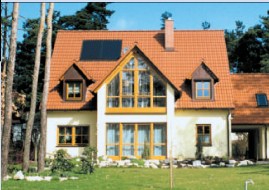
11 Kolektory najlepiej jest montować na południowej połaci dachu (fot. Wolf)
