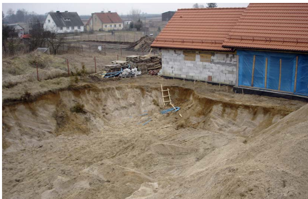
▼ Głęboki wannowy wykop wykonany w celu ułożenia kolektora płaskiego
