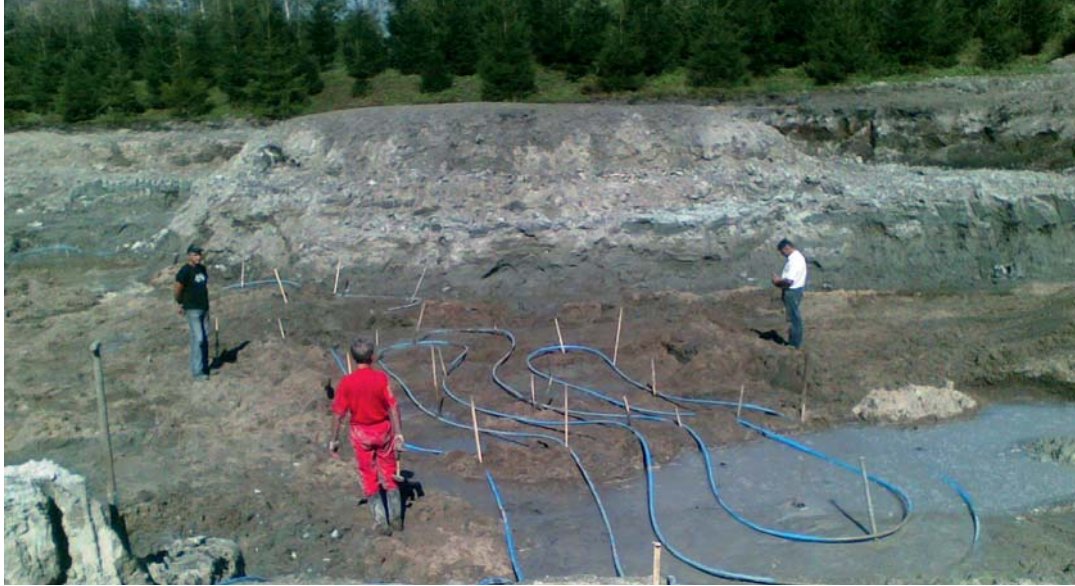
▲ Układanie rurek kolektora sposobem meandrowym. Na drugim planie widoczna jest wyspa, która będzie leżała na środku jeziora
