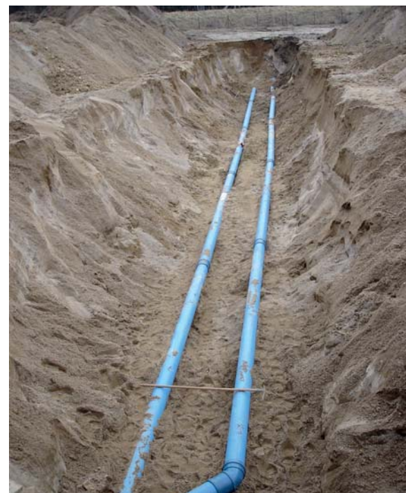
▼ Gruntowy wymiennik ciepła ułożony w Sołdanach Nowych
