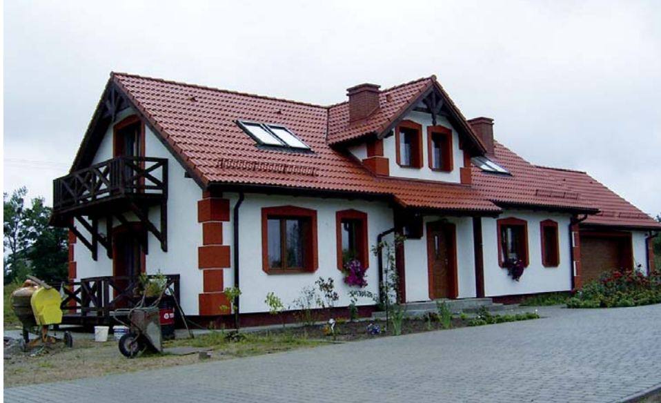
▲ Dom w Söldanach Nowych – miejsce drugiej inwestycji
