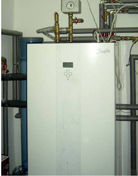
▲ Pompa ciepła DHP-L 10
