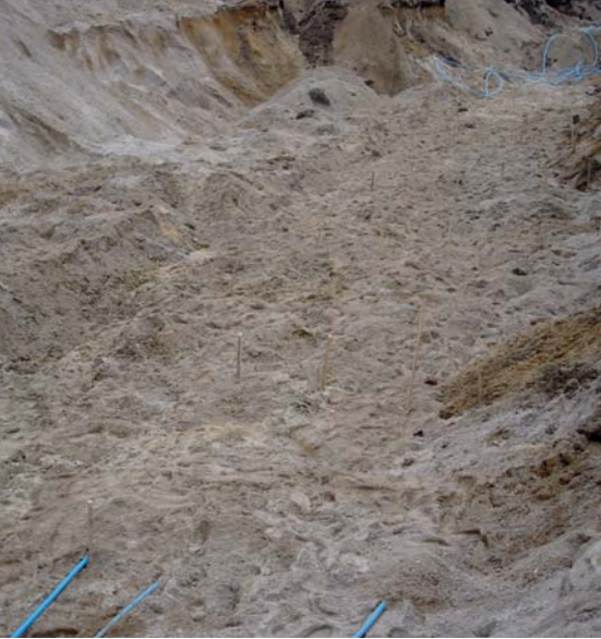
▲ Pierwsza warstwa kolektora płaskiego w Sołdanach Nowych, przysypiana częściowo gruntem
