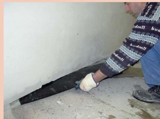
▲ Ułożenie izolacji wodoszczelnej
