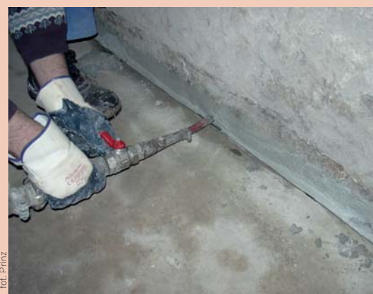
▼ Wtłoczenie pod ciśnieniem zaprawy
