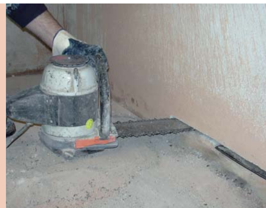
▲ Wykonanie izolacji poziomej. Przecięcie muru za pomocą piły łańcuchowej
