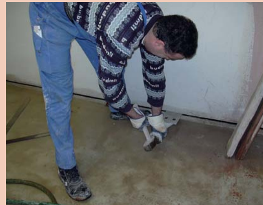
▼ Wtłoczenie pod ciśnieniem zaprawy
