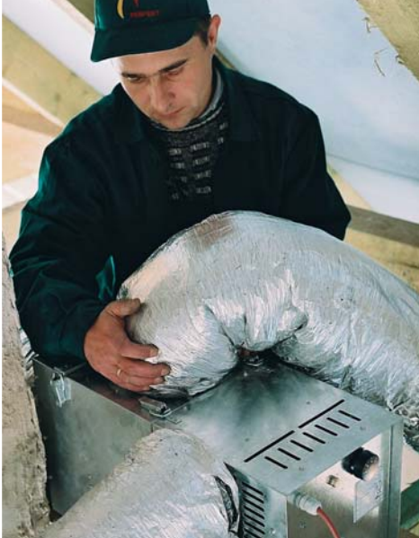
Łącząc kanały z dmuchawą trzeba pamiętać o dokładnym sprawdzeniu szczelności połączeń
