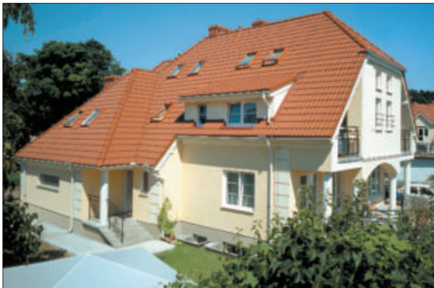
8 Dachówki cementowe nie różnią się wyglądem od ceramicznych (fot. Braas)
