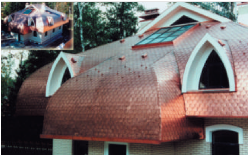
13 Dachówki bitumiczne pokryte folią miedzianą (fot. Tegola Polonia)
