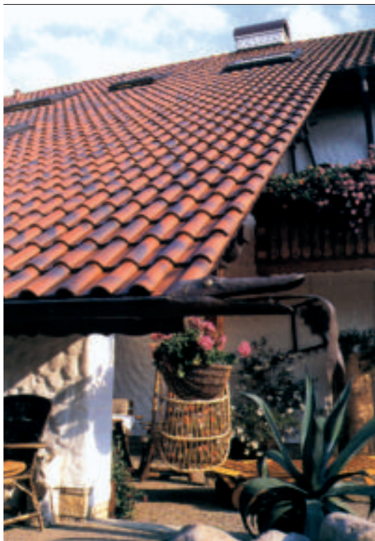
6 Dachówka z angobą w dwóch kolorach (fot. RuppCeramika)
