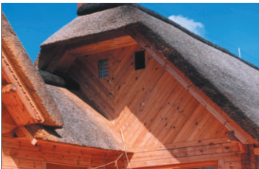
19 Strzecha trzciniowa szarzeje z upływem czasu (fot. LML Ekodach)
