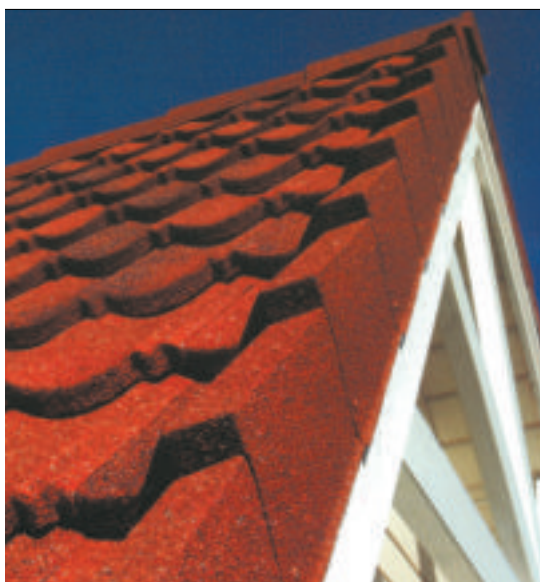
10 Wielowarstwowy materiał pokryciowy z rdzeniem stalowym i mineralną posypką jest bardzo trwały i efektowny (fot. Icopal)
