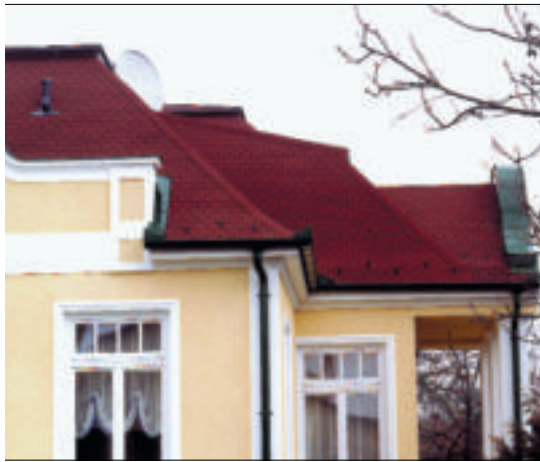
12 Dach kryty gontami bitumicznymi (fot. IKO)
