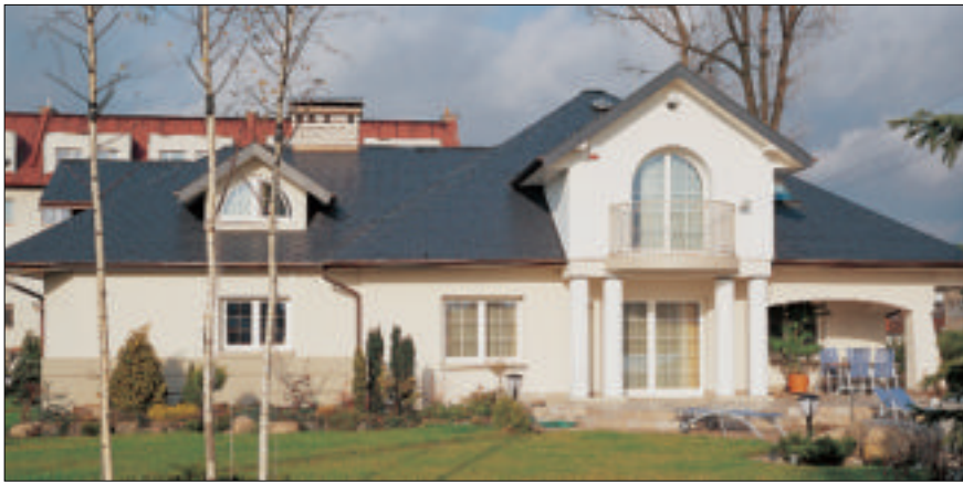
16 Płytki włóknisto-cementowe mogą imitować łupek (fot. Euronit)
