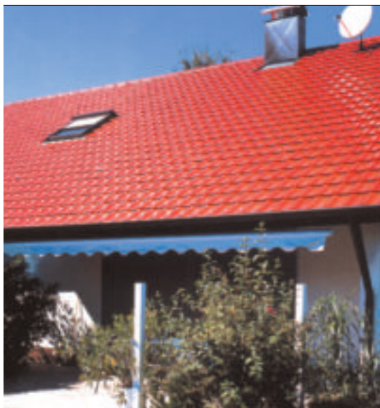
7 Dachówki glazurowane mają szczególnie gładką powierzchnię (fot. Creaton)
