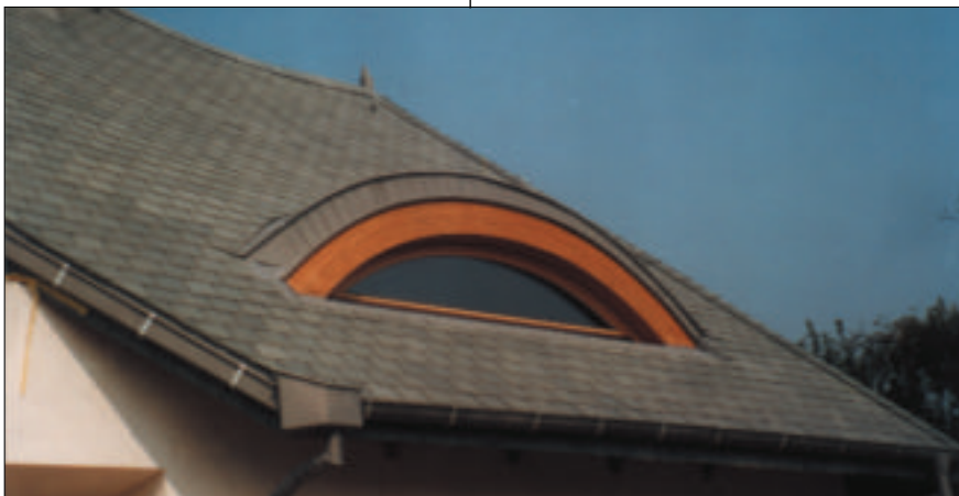
17 Dach kryty łupkiem naturalnym (fot. Rustico)
