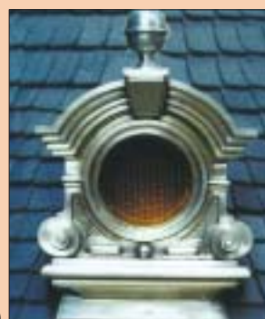
6 Ozdobna lukarna wykończona blachą cynkowo-tytanową (fot. Radosz Metaloplastyka)
