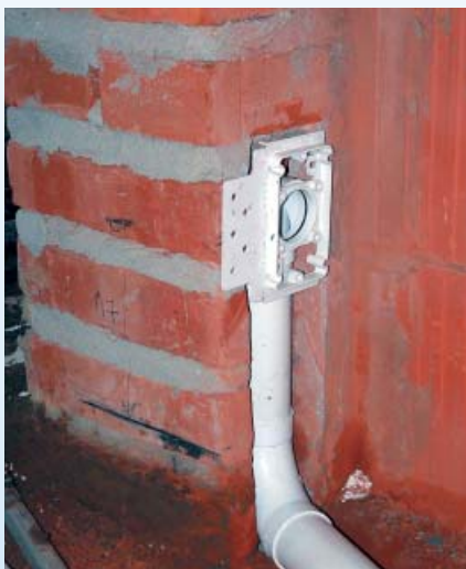
Możemy montaż centralnego odkurzacza rozłożyć na dwa etapy: montaż instalacji w ścianach oraz zakup akcesoriów i jednostki centralnej (fot. Husky)
