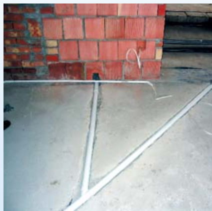
Możemy montaż centralnego odkurzacza rozłożyć na dwa etapy: montaż instalacji w ścianach oraz zakup akcesoriów i jednostki centralnej (fot. Husky)
