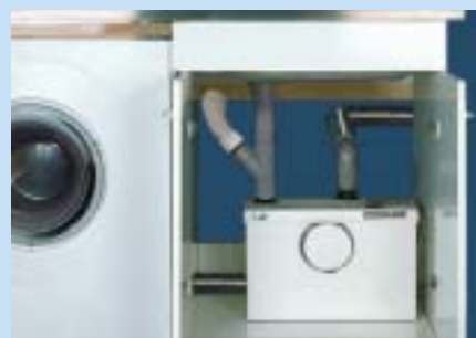
b – Przystawka podłączona do kilku urządzeń sanitarnych, w tym m.in. do pralki (fot. Borysowski & Spółka)
