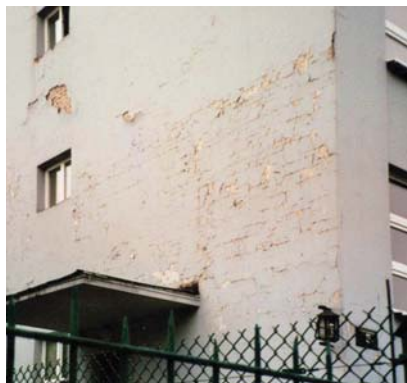
7 Przy odnawianiu elewacji wykonanej w tynkach wapienno-cementowych zastosowano wyprawy tynkarskie nieprzepuszczalne dla pary wodnej
