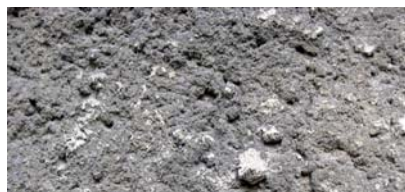
2 Struktura 70-letniego grubowarstwowego tynku wapiennego. Brak widocznych uszkodzeń
