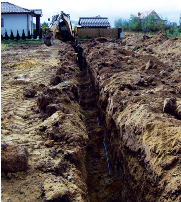
Aby nie uszkodzić rurek kolektora, w którym znajduje się gaz propan R 290, prace bezpośrednio przy wiązkach wykonuje się łopatą
