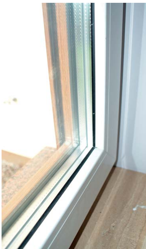
▲ Okna w domu wyposażone są w trzy szyby. Dodatkowo przed utratą ciepła zabezpieczają je rolety zewnętrzne
