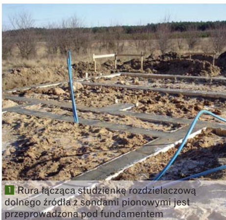
2 W taki sposób nie należy wprowadzać rur z glikolem do budynku, gdyż fundament zostaje uszkodzony
