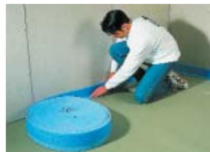
Układanie przyściennego paska dylatującego i tłumiącego – tu bez folii izolacyjnej (fot. Rigips)
