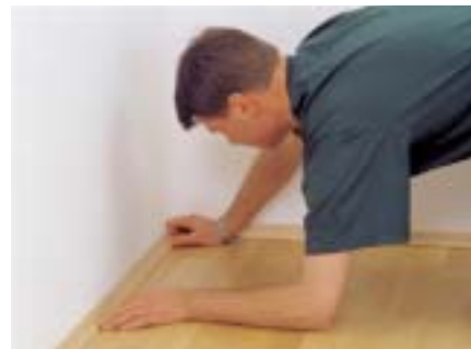
Etapy układania paneli jako podłogi pływającej (fot. Barlinek)
