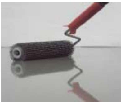
Bardzo ważne jest odpowietrzanie wylewki samopoziomującej (fot. Henkel Polska)
