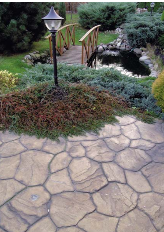
▲ Beton stemplowany nie ma fug, dlatego mniej ma miejsc, przez które woda mogłaby przesiąknąć w głąb tarasu
