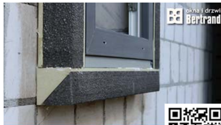
Montaż systemem MOWO
