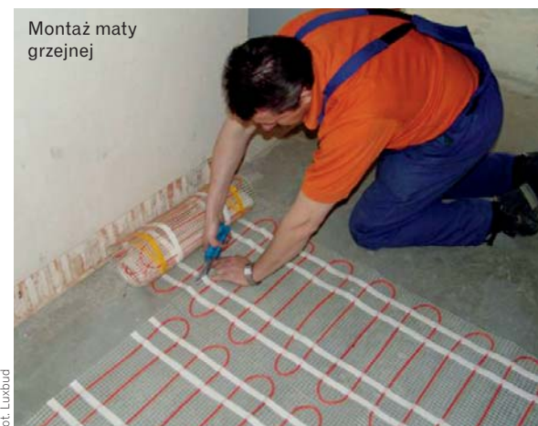
▲ Elementy elektryczne ogrzewania podłogowego z matą grzewczą
