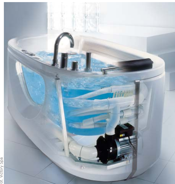
▲ Przekrój wanny z hydromasażem
