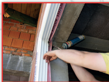
Wykonanie uszczelnienia pianką poliuretanową SOUDAFOAM tworzącą warstwę izolacji termicznej
