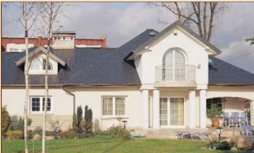
6 Dach pokryty płytkami Struktonit imituje łupek (fot. Euronit)
