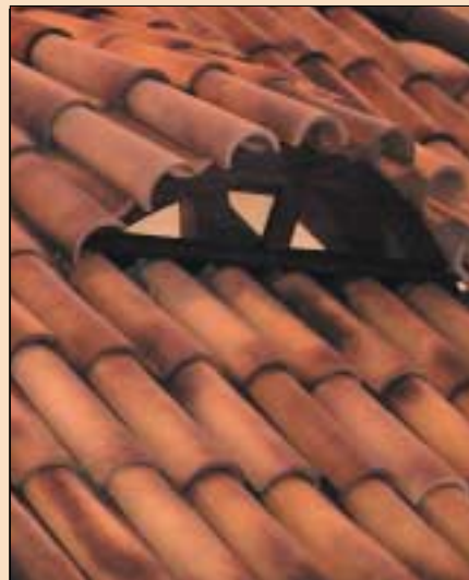
3 Dachówki cieniowane celowo postarzają dach (fot. FCB)
