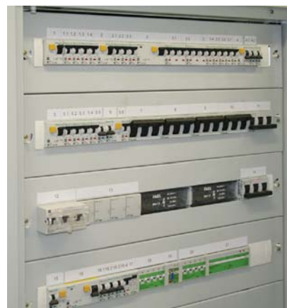
▲ Rozdzielnica systemu, w którym zamontowana jest instalacja hybrydowa składająca się z EIB i klasycznej
