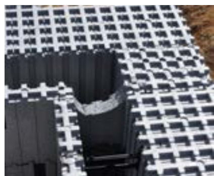
Usunięcie fragmentu elementu zapewnia ciążłość wypełnienia betonem.
