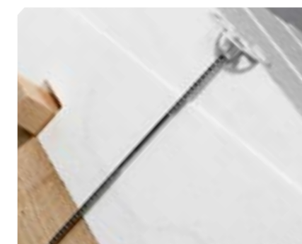
Kolek rozporowy do montowania płyt dachowych Izodom.
