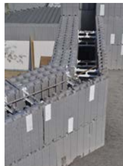
Zastosowanie elementów zawiasowych do kształtowania narożników pod dowolnym kątem.
