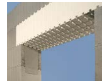
Nadproże. Element nadprożowy w przekroju ma kształt litery U.
