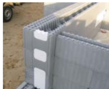
Budując ościeża i tępe zakończenia ścian - otwory w szalunku, zamykamy elementami OH, OB i OC.
