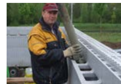
Układając beton pompą z prędkością podawania 6 - 9 m 3 , możemy wypełnić od 40 do 70 m 2 ścian w zaledwie 1 godzinę!
