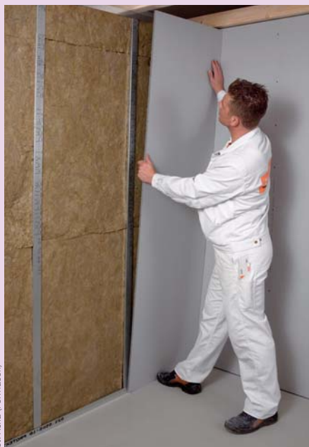
▲ Ściany działowe z płytami gipsowo-włóknowymi umożliwiają wykańczanie jednym rodzajem okładzin wszystkich pomieszczeń – także „mokrych”
