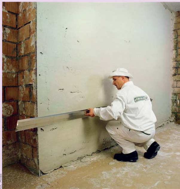
▲ Jednowarstwowy tynk gipsowy, jako łatwiejszy i szybszy do układania obecnie powszechnie stosowany jest na ścianach murowanych
