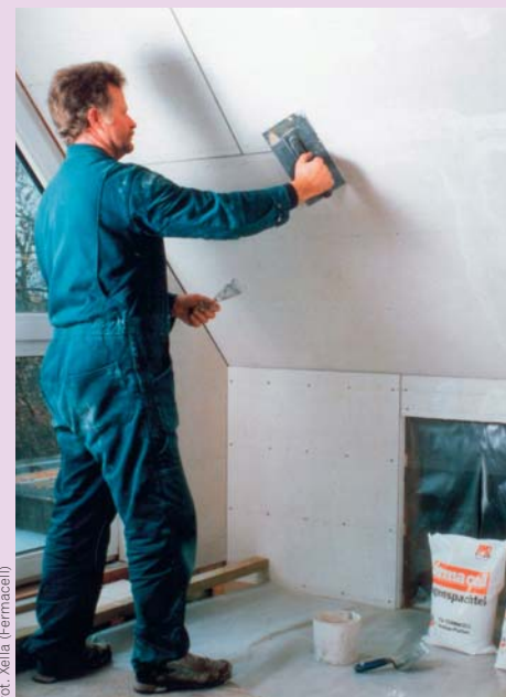
▲ Okładziny gipsowo-kartonowe to niemal nieodłączny element wykończenia poddaszy – powinny mieć zwiększoną odporność ogniową
