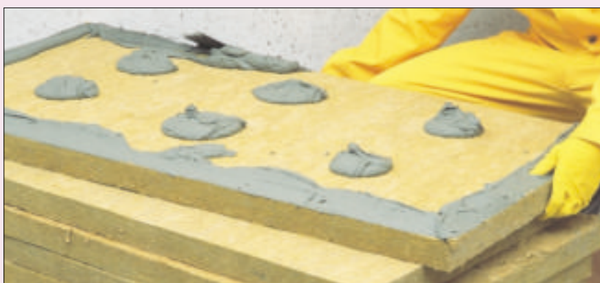
2 Standardowe płyty z wełny mineralnej; przygotowywanie do przyklejenia (fot. Henkel)
