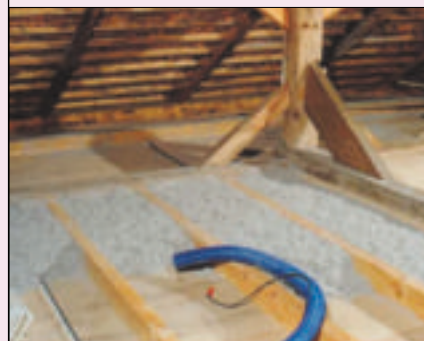
11 Nadmuchiwanie termoizolacji w konstrukcję stropu (fot. NEF Polska)
