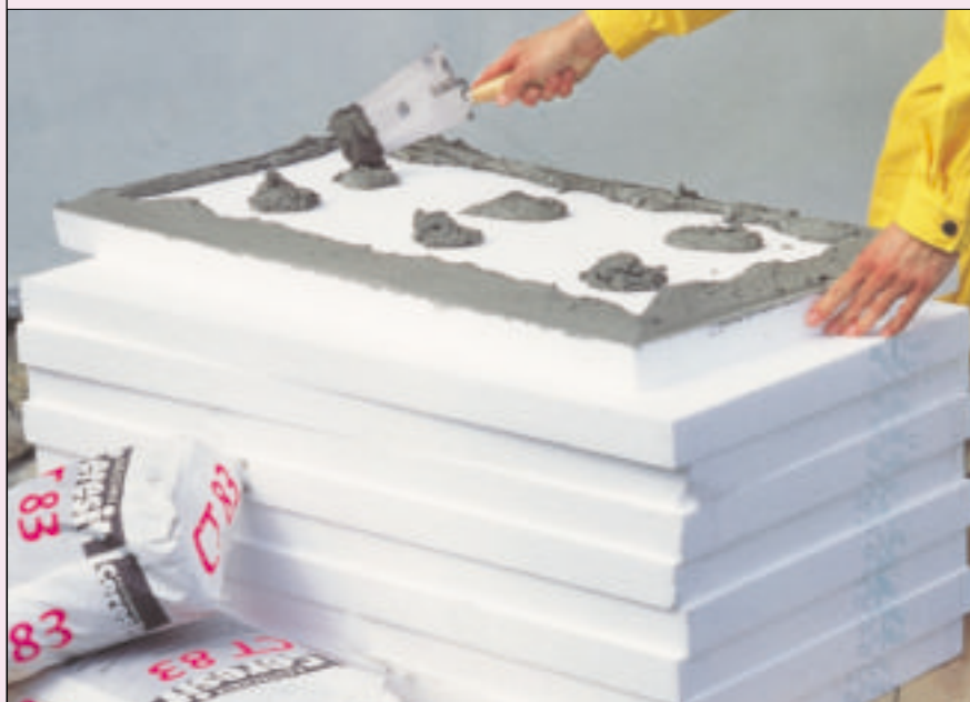
6 Płyty styropianu; przygotowanie do przyklejenia (fot. Henkel)
