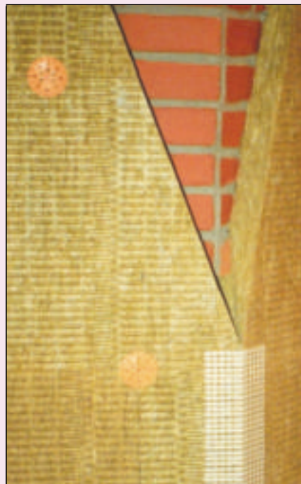
3 Płyta z wełny mineralnej o nieregularnym układzie włókien
