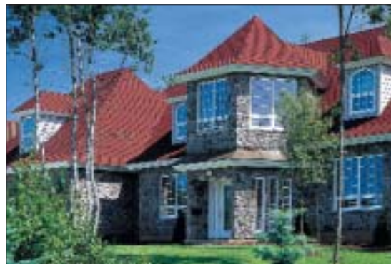
Gontem bitumicznym pokryjemy dach o najbardziej skomplikowanej formie (fot. IKO)
