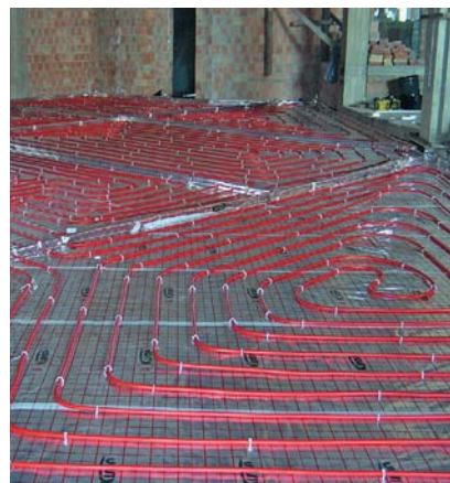
Tradycyjna instalacja ogrzewania podłogowego – rury grzejne ułożone na ociepleniu zalewa się warstwą jastrychu... ▲
