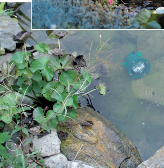
▲ Oprawy oświetleniowe umieszczone w oczku wodnym muszą mieć klasę ochronności elektrycznej III i stopień szczelności IP68
